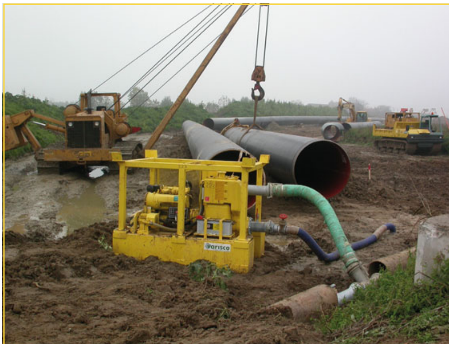
Drenážne výkopy pre inštaláciu potrubia Drainage excavation for pipeline installation Drenaje de las excavaciones para puesta metanoducto
